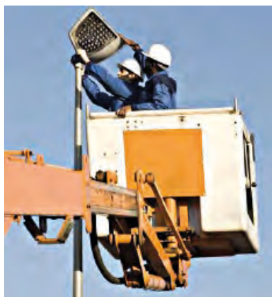
Figura 8. Mantenimiento de luminarias.
