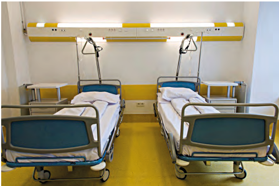
Figura 24. Ejemplo de iluminación en hospitales.
