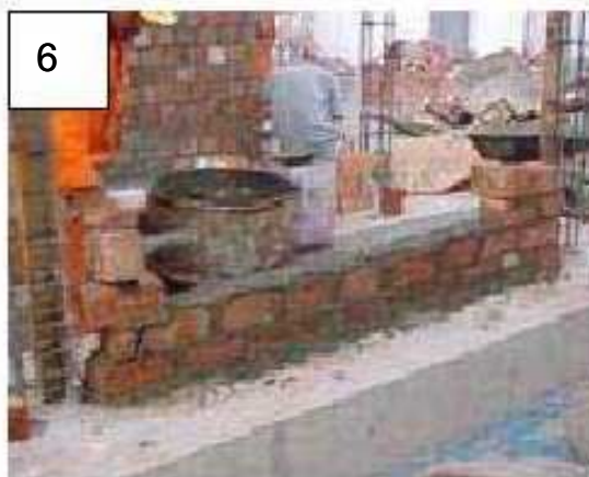
6 Con la ayuda del escantillón y un cordel amarrado entre los dos extremos se verifica la altura de cada hilada, incluyendo el espesor de la junta. Así, los dos ladrillos maestros tienen la misma altura y alineación, para que los otros ladrillos a ser asentados tengan también el mismo espesor de junta.
