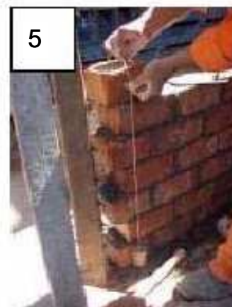
5 La verticalidad de cada hilada debe ser verificada con la plomada y la altura de cada hilada con el escantillón (regla graduada)
