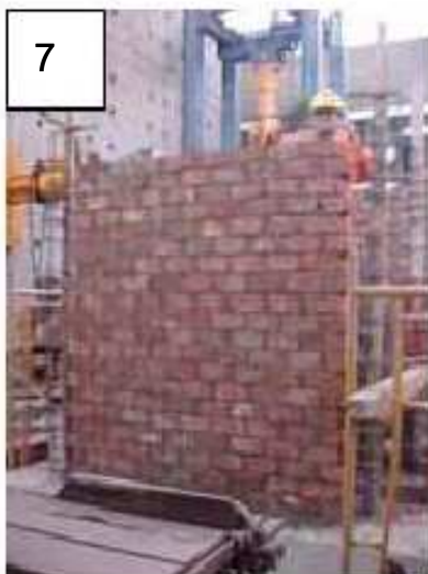
7 El muro alcanza su altura final.
