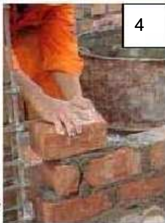
Colocar los ladrillos sobre la cama de mortero en las esquinas, los que serán ladrillos maestros (guías)
