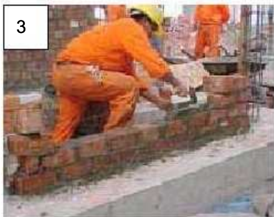
3 Usando el badilejo se coloca la mezcla sobre los ladrillos de manera que penetre en la junta entre ladrillos.
