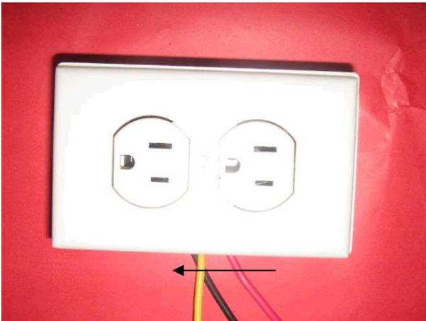
Es donde se guarda el tomacorriente doble con espiga a tierra y son adosables para pared. Se coloca sobre la canaleta usada para la parte eléctrica
