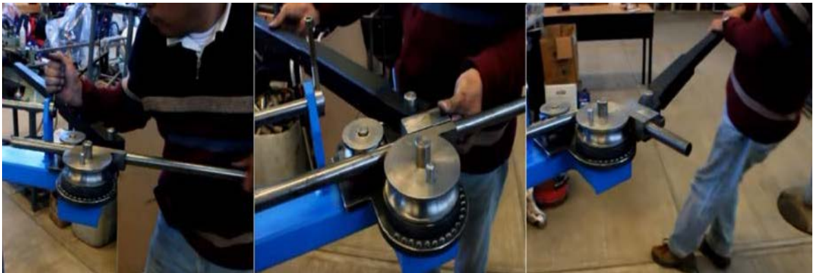
Figura 1. Proceso de doblado de tubos.
