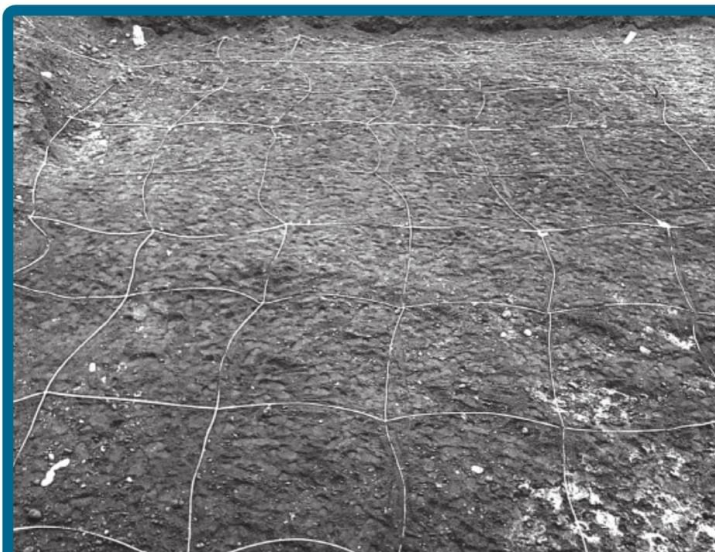
Malla de puesta a tierra, que puede ocupar grandes extensiones.
