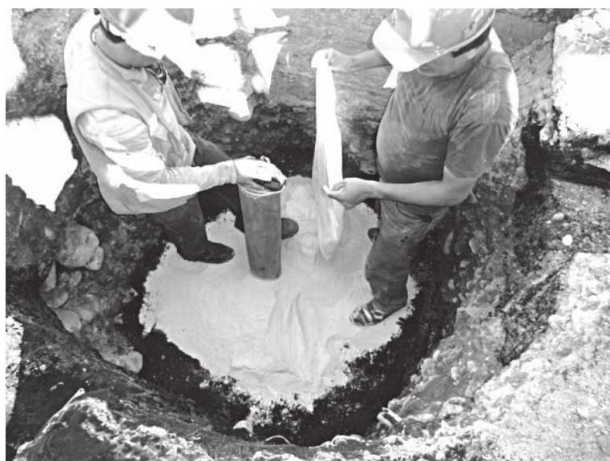
Tratamiento en la zona de colocación de la jabalina de puesta a tierra con bentonita.
