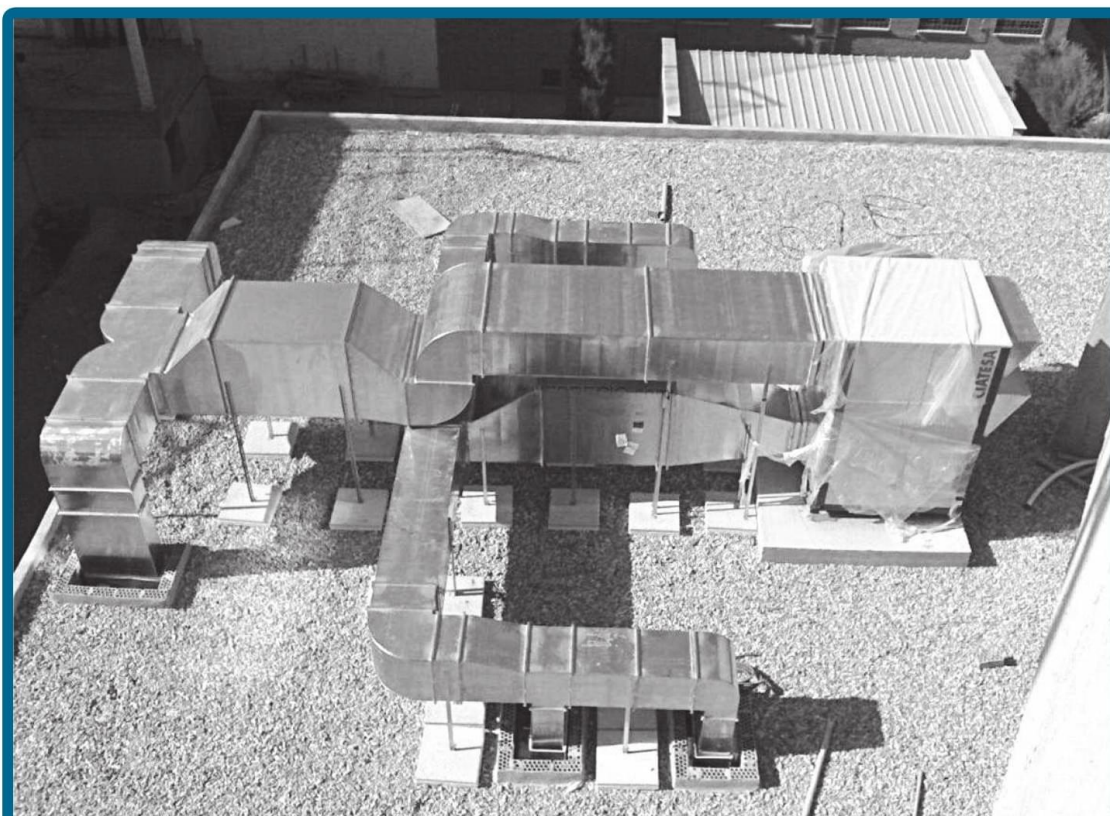
Instalación de un equipo acondicionador de aire frío/calor central.
