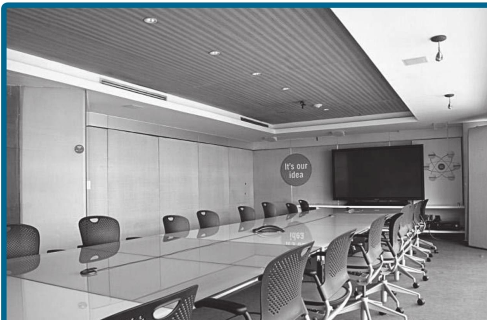
Vista de una sala de reuniones. Los tomacorrientes de uso general y especial se hallan ubicados en el piso a través de piso ductos y en las paredes.
