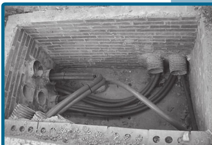
Este es un cable para tendido subterráneo. Es el recomendado para este tipo de instalaciones ya que su recubrimiento está especialmente diseñado para durar muchísimos años.
