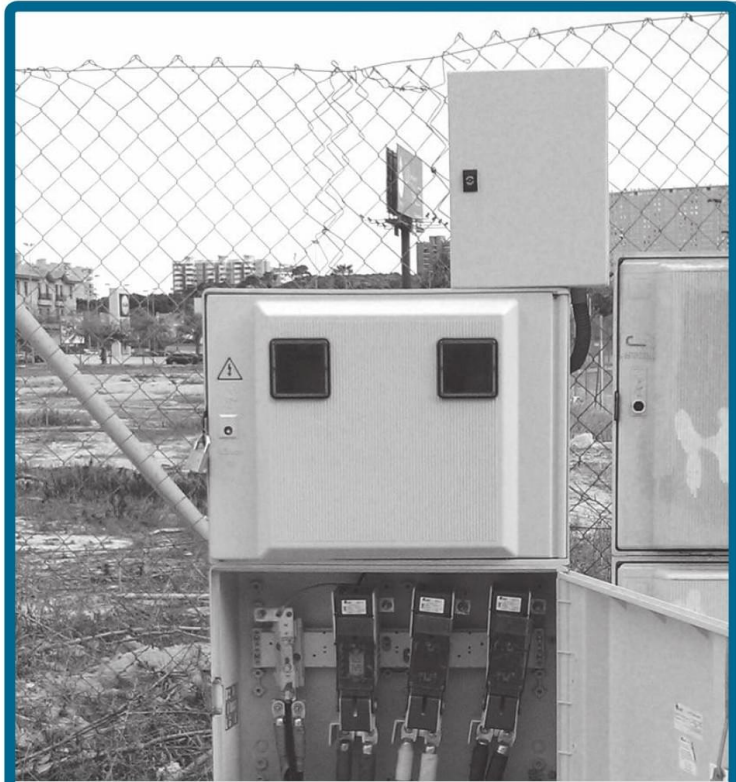
Típico conexionado en un buzón de distribución donde vemos cómo se deriva hacia una línea de alimentación.
