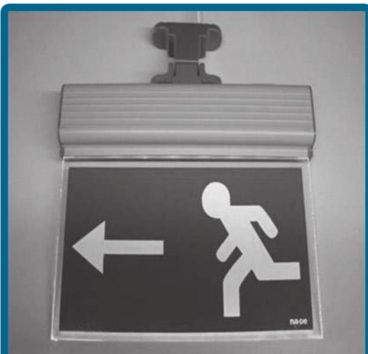
Equipo autónomo de indicación de salida de emergencia.
