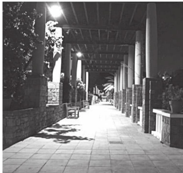
La iluminación de espacios semicubiertos o descubiertos debe ser realizada con circuitos IUE.
