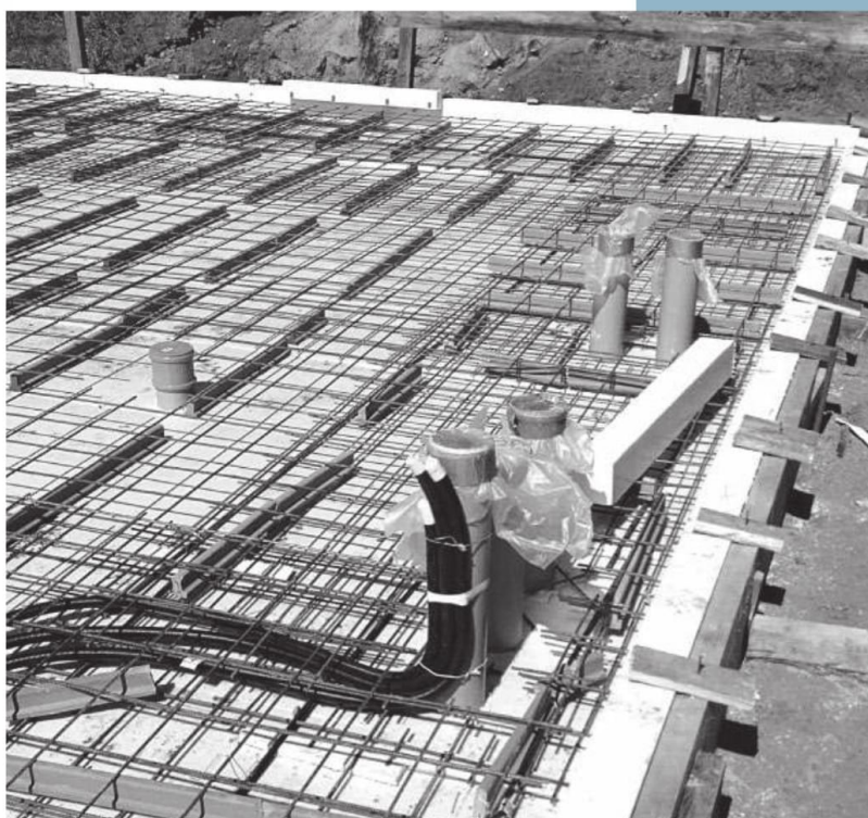
Realización de instalaciones debajo de un piso.
