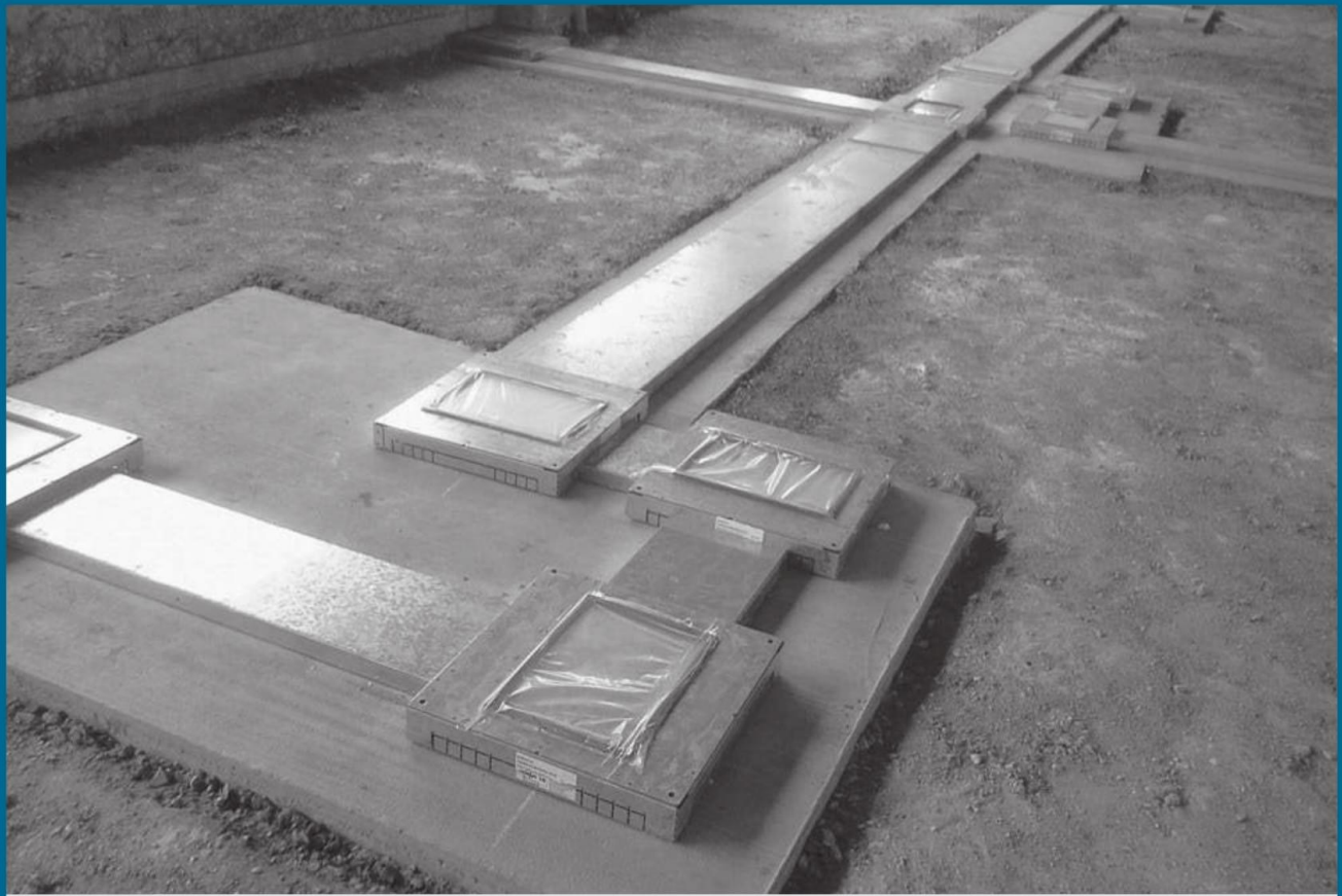
Empleando piso ductos se pueden armar islas de trabajo sin crear obstáculos para el pasaje de cables de electricidad, datos y telefonía.
