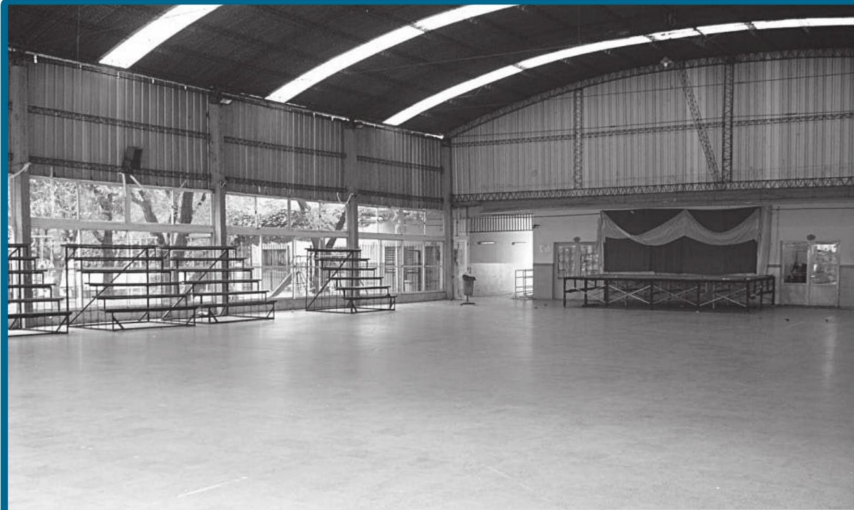
Patio cubierto y gimnasio de un colegio. Nótese las luminarias suspendidas del techo, fuera del alcance normal de los alumnos y protegidas con rejillas metálicas.
