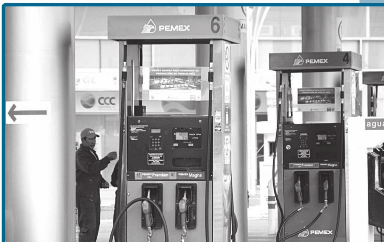
Estación de venta de gasolina, las partes metálicas se encuentran conectadas a tierra.
