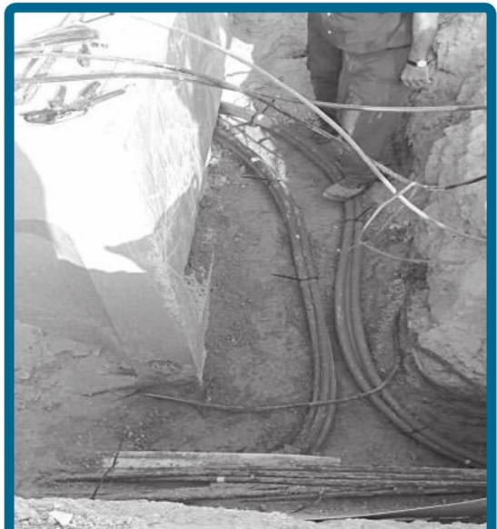
Instalación subterránea de cables.
