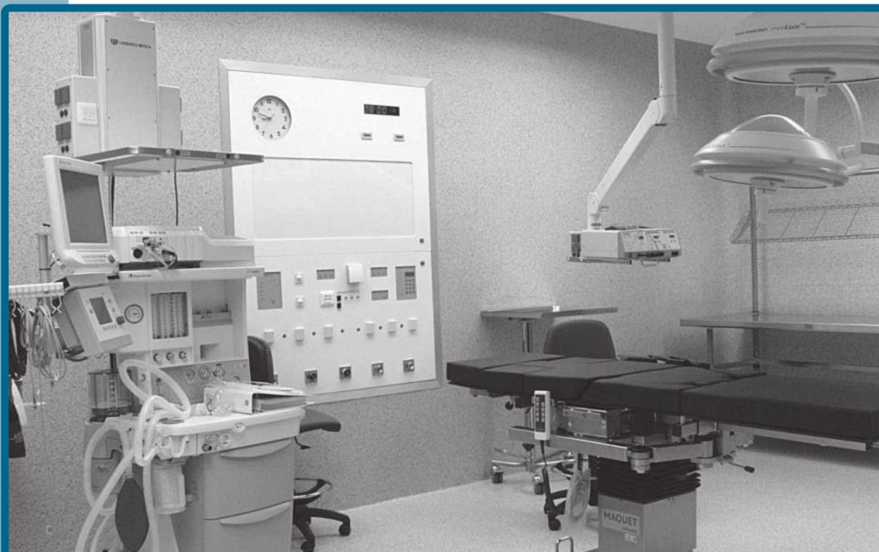
Quirófano, ejemplo de sala del grupo 2 a.
