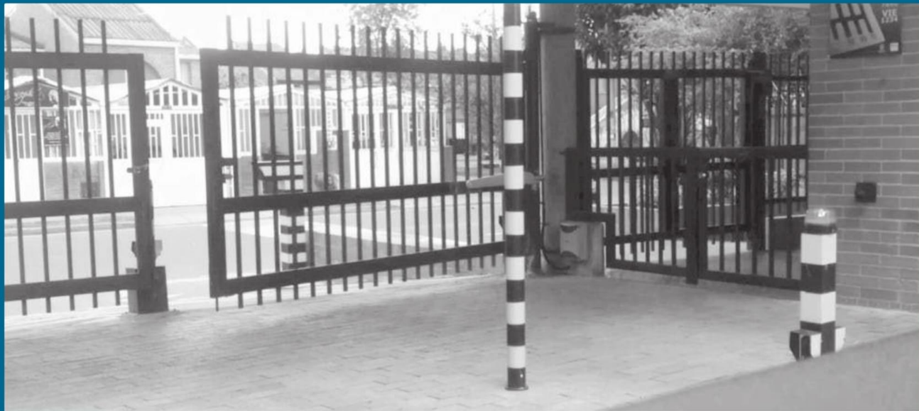
Portón industrial automatizado de tipo batiente de dos hojas con rejas optimizado para acceso vehicular.
