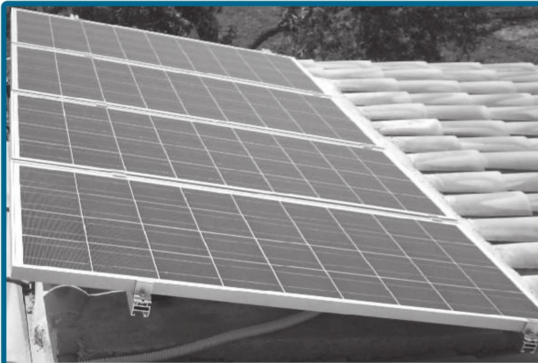
Panel solar de 50 watts para aplicaciones de baja potencia donde se aprecian sus elementos fundamentales, las células fotovoltaicas.
