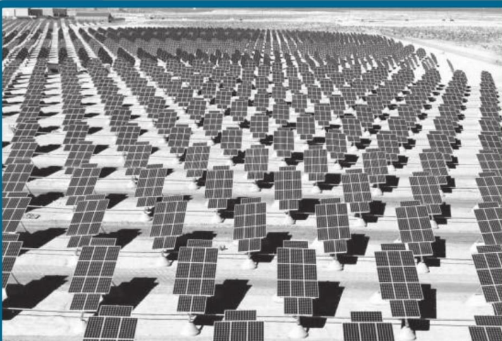
Planta fotovoltaica generadora de electricidad capaz de contribuir a controlar los picos de consumo si se conecta a la red eléctrica.
