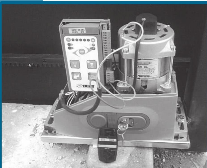
Partes del automatismo incluidos motor, mecanismos y control. Veamos con qué facilidad se reemplaza cualquiera de ellas.
