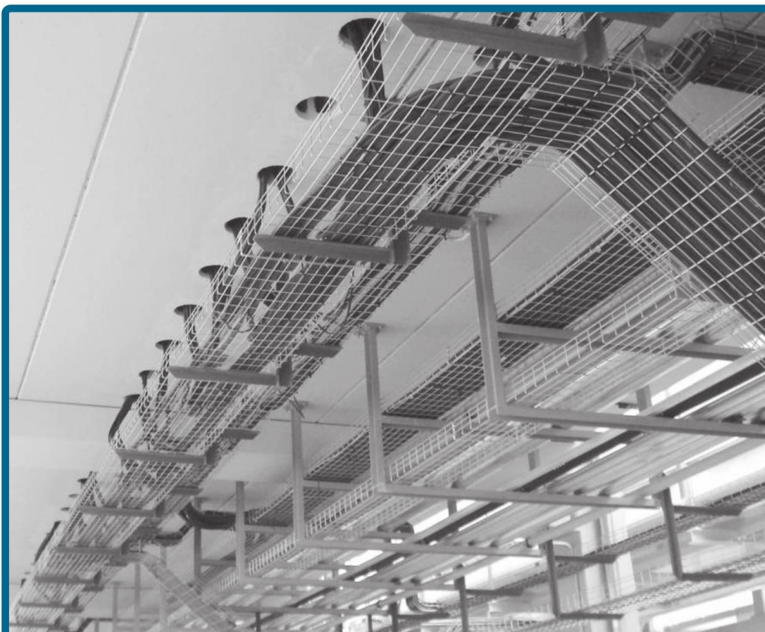
Canalizaciones aéreas en bandejas portables.
