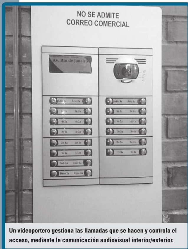
En un sistema portero convencional, la llamada en una vivienda se genera presionando el pulsador adecuado en la placa de calle.
