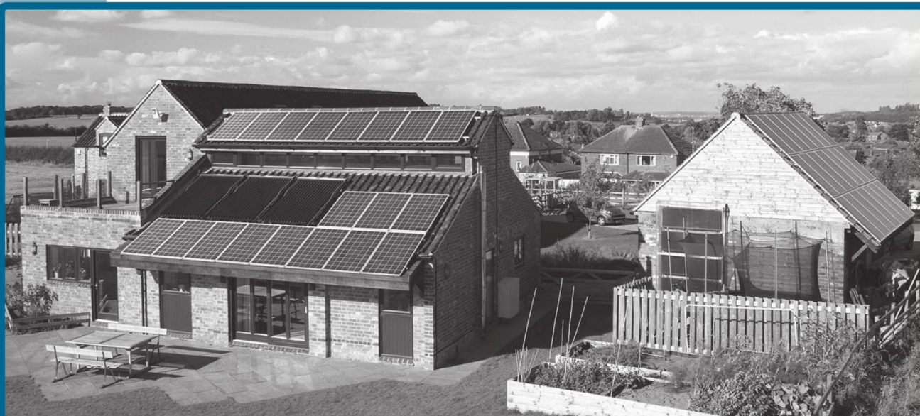
Paso 1: determinar el lugar óptimo, considerando la capacidad del sistema fotovoltaico, la cercanía física, la orientación y dirección del sol.
