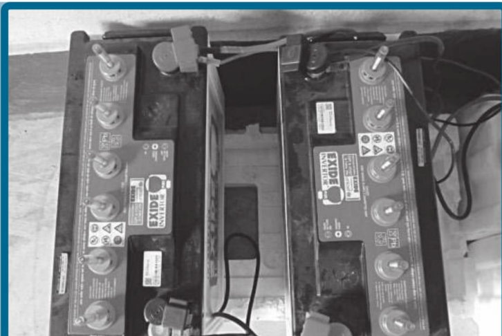
Paso 5: instalación de la batería. Instalaremos la batería sobre una base aislada en un lugar protegido de la intemperie, seco y ventilado.
