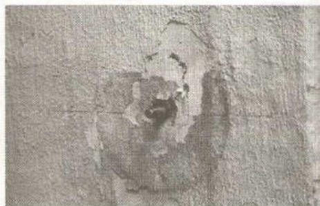
Figura I6-60. Anclaje enterrado en el muro
