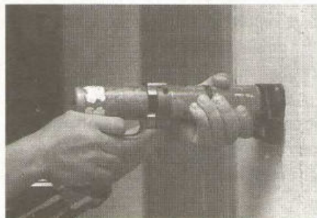
Figura I6-59. Disparando el anclaje
