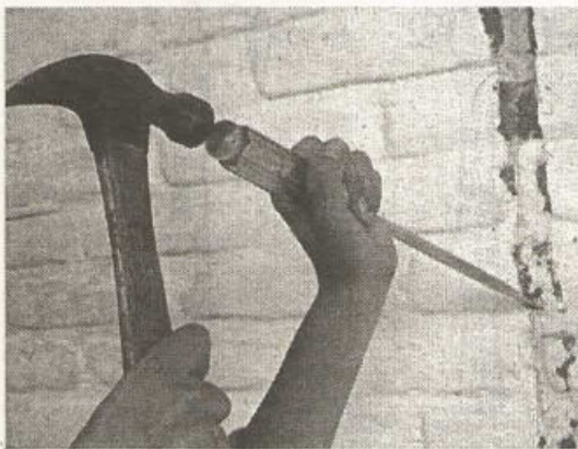
Figura I6-15. Forma de utilizar un martillo para abrir regatas
