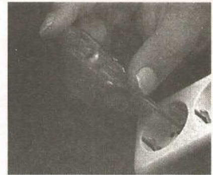
(a) Detección del conductor de fase con un probador unipolar
