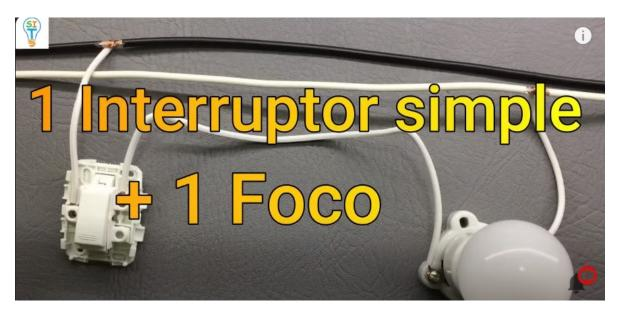
Bueno vamos con el primer caso que es un interruptor con un foco entonces básicamente siempre vamos a tener una línea que es fase y el neutro o sea que vamos a colocar fase y neutro
