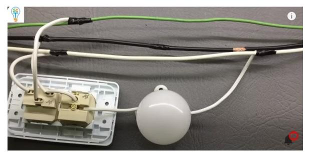
Entonces en este momento vamos a hacer la prueba para encender y apagar el foco por lo menos, aunque el toma también estaría funcionando vamos a conectar y ahí está encendido porque el switch estaba en ON
